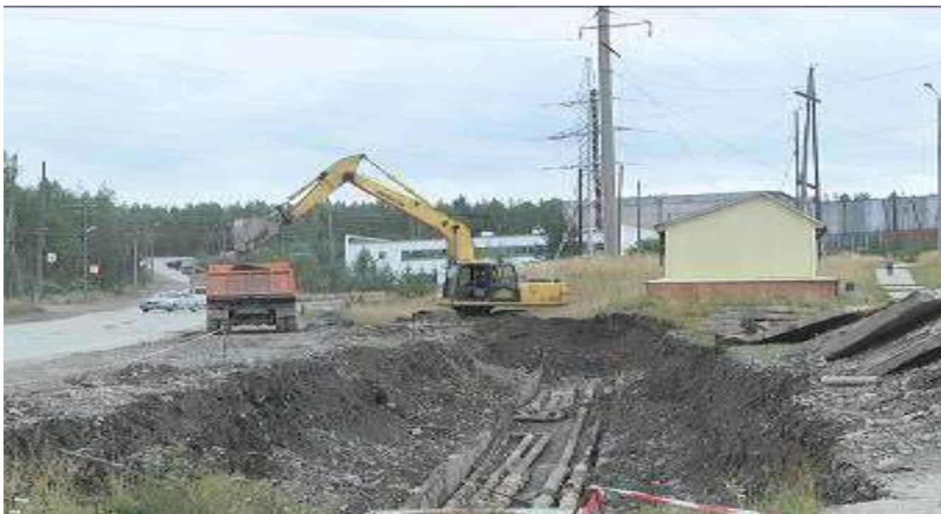
Капитальный ремонт участков сети тепловодоснабжения в гп Северо-Енисейский
